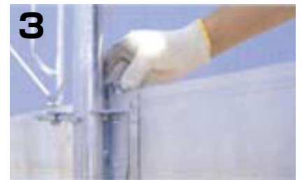
3 外れ止めロック装置をセット
