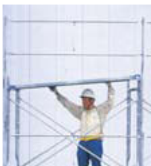
⑤ 布板(足場板)の取り付け
