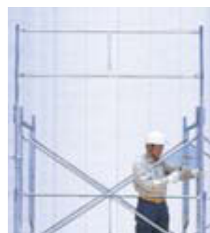
④ 手すりユニットを持ち上げ、建枠上端に差し込み取り付け
