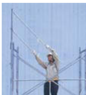
② 先づけ手すり柱に、二段手すりの差し込み、取り付け
