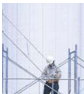
③ もう一方の先づけ手すり支柱に二段手すりの取り付け
