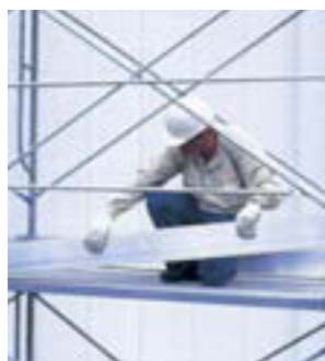
⑦ つま先板の取り付け
