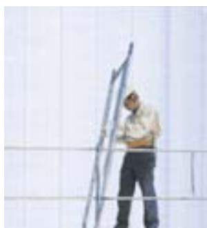
⑥ 上段の建枠、ブレースの組み立て
