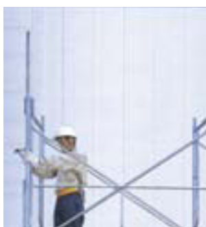
① 建枠上端に先づけ手すり支柱の差し込み、取り付け
