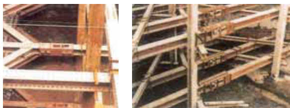
施工現場使用例
